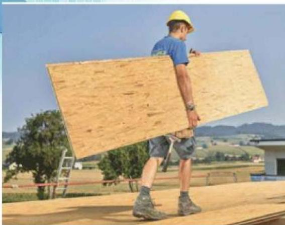
OSB là viết tắt của Oriented Strand Board, ván sợi dăm gỗ là sản phẩm làm từ các sợi gỗ mỏng được gia cố, kết dính cùng một loại nhựa tổng hợp thành khối đồng nhất. Ván Toàn Cầu OSB (Toàn Cầu TegoDeck OSB Tongue & Groove và Toàn Cầu Board OSB/3) bao gồm ba lớp định hướng chéo với bề mặt của bảng được hình thành từ các sợi được định hướng dọc theo chiều dài của bảng và các sợi lõi được sắp xếp theo hướng chéo.
